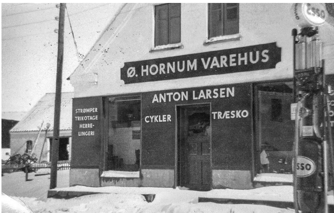
Varehuset ca. 1948. Skiltet med "Ø. HORNUM VAREHUS" og panelerne mellem vinduerne var vinrøde.
