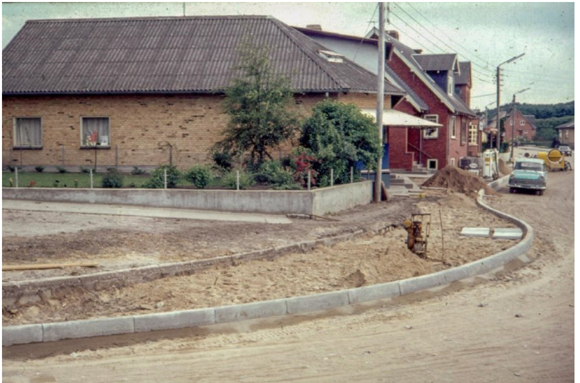
Kloakeringen er ved at være gennemført, og der etableres ny fortove med ekstra sving på.
